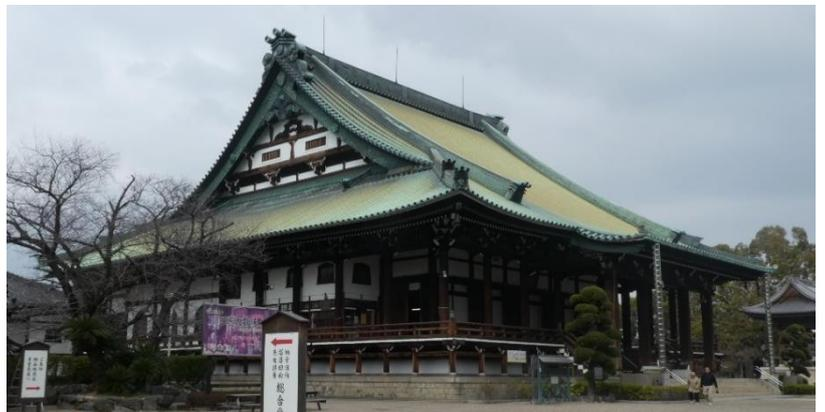
本堂は、総檜造り銅板葺き。前身建物の焼失後、ほぼ同規模で建設された。入母屋造、平入で、桁行7間、梁間8間、建築面積1217㎡。屋根は本瓦葺を模した銅板葺。内部は小組格天井を高く張り、正側面に縁を巡らし背面側には廊下を通す。昭和13年(1938)再建の大阪府下最大の木造建築。平成15年に国の登録有形文化財指定
